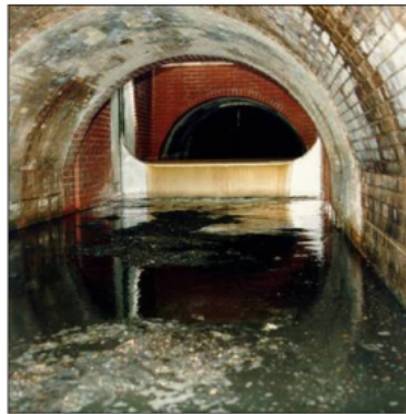
Berliner Wasserbetriebe für Studie „Ökologisches Bauen“ 2010: „Regenüberlaufwehr“
