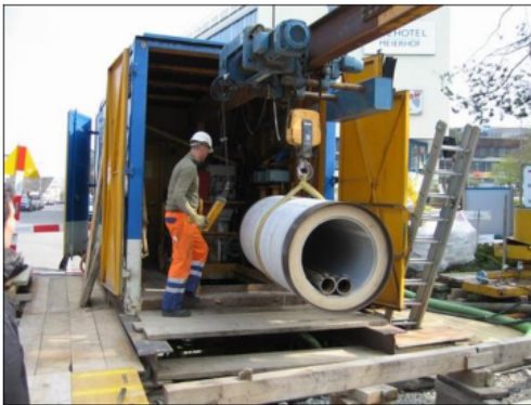
Einbau von Abwasserrohrelementen zur Sanierung von Bruchschäden
